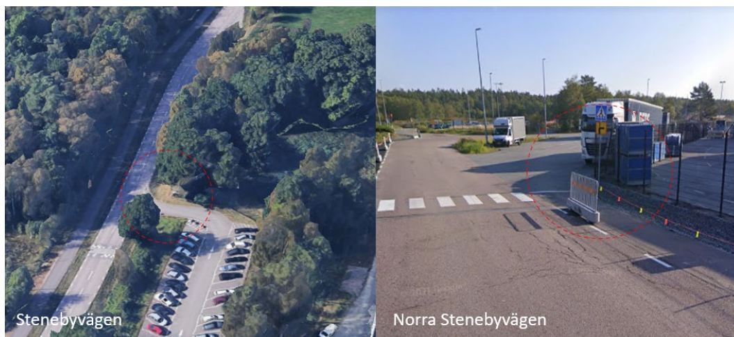
Figur 12. Bristande siktförhållande på Stenebyvägen och Norra Stenebyvägen.
